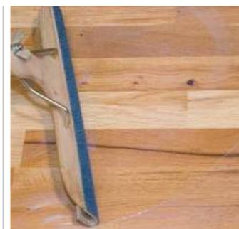
5. В качестве поверхностного покрытия нанесите 2-3 слоя лака Паркетти-Ясса, используя флотексный или мохеровый шпатель, кисть - для дощатых полов кисть. Полуматовый и полуглянцевый лак можно также наносится валиком в 1-2 слоя. Дайте поверхности просохнуть в течение 3 часов между нанесениями лака. При необходимости слегка зашлифуйте поверхность и удалите шлифовальную пыль.
